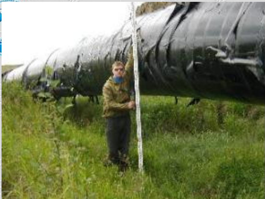
Выпучивание магистрального газопровода (подземная прокладка 1993г)
