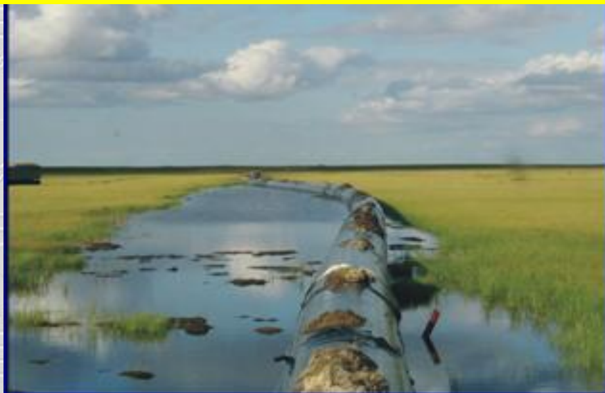
Выпучивание магистрального газопровода (подземная прокладка 1993г)
